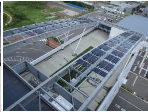
太陽光パネル
