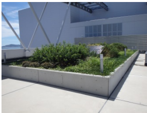
屋上緑化庭園
